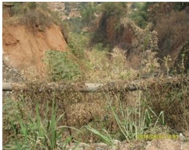
Figure n°16 : La conduite principale de la REGIDESO exhumée par l'érosion
