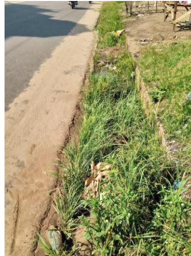
Figures 14. Photos de l'état des caniveaux de 523, de Kilokoko et de Mutangu après la pluie
